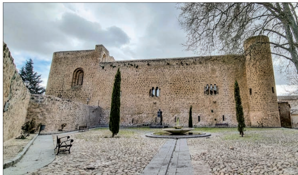
Rehabilitadas las murallas en el entorno del castillo.
