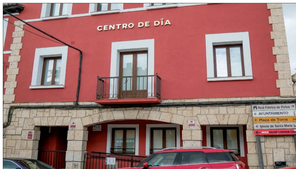
El Centro de Día se ubica en la Avenida Constitución del pueblo.
