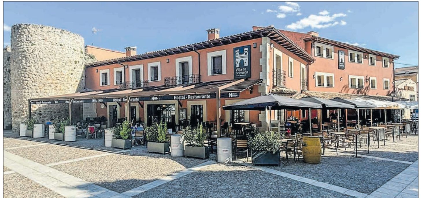
El edificio del Villa de Brihuega se ha sometido a una renovación integral.
